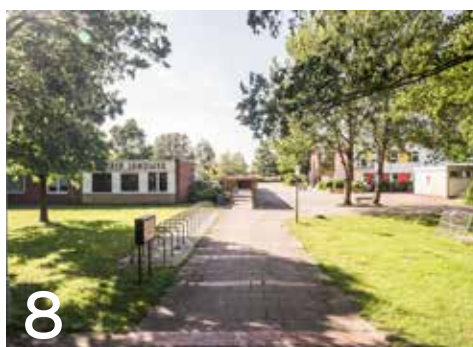
8 Blick auf die Schule Mittlerer Landweg
