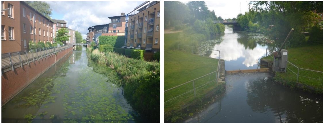
Abb. 2-1: Fleetsystem von Neuallermöhe (links) mit einem beweglichen Wehr (rechts), (Fotos IOW, Juli 2020)
