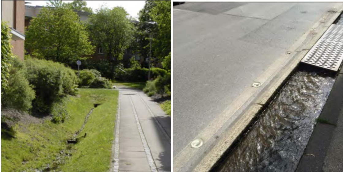
Abb. 5-10: Beispiele für die Ableitung von Regenwasser über Gräben in Hamburg (links) bzw. über eine offene Kastenrinne im Straßenraum in Aachen (rechts) [30]
