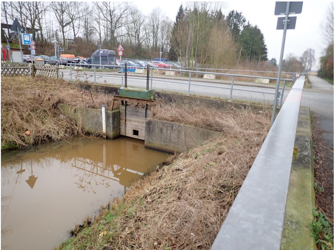
Abb. 2-9: Absperrbauwerk am Mittleren Landweg (Begehung IOW, Februar 2020)
